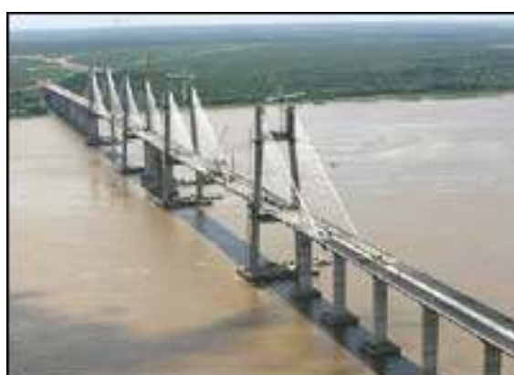
Detalhe da Ponte sobre o rio Orenoco, Venezuela
