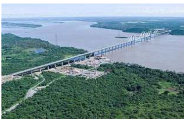
Visão Panorâmica da Ponte sobre o rio Orenoco, Venezuela
