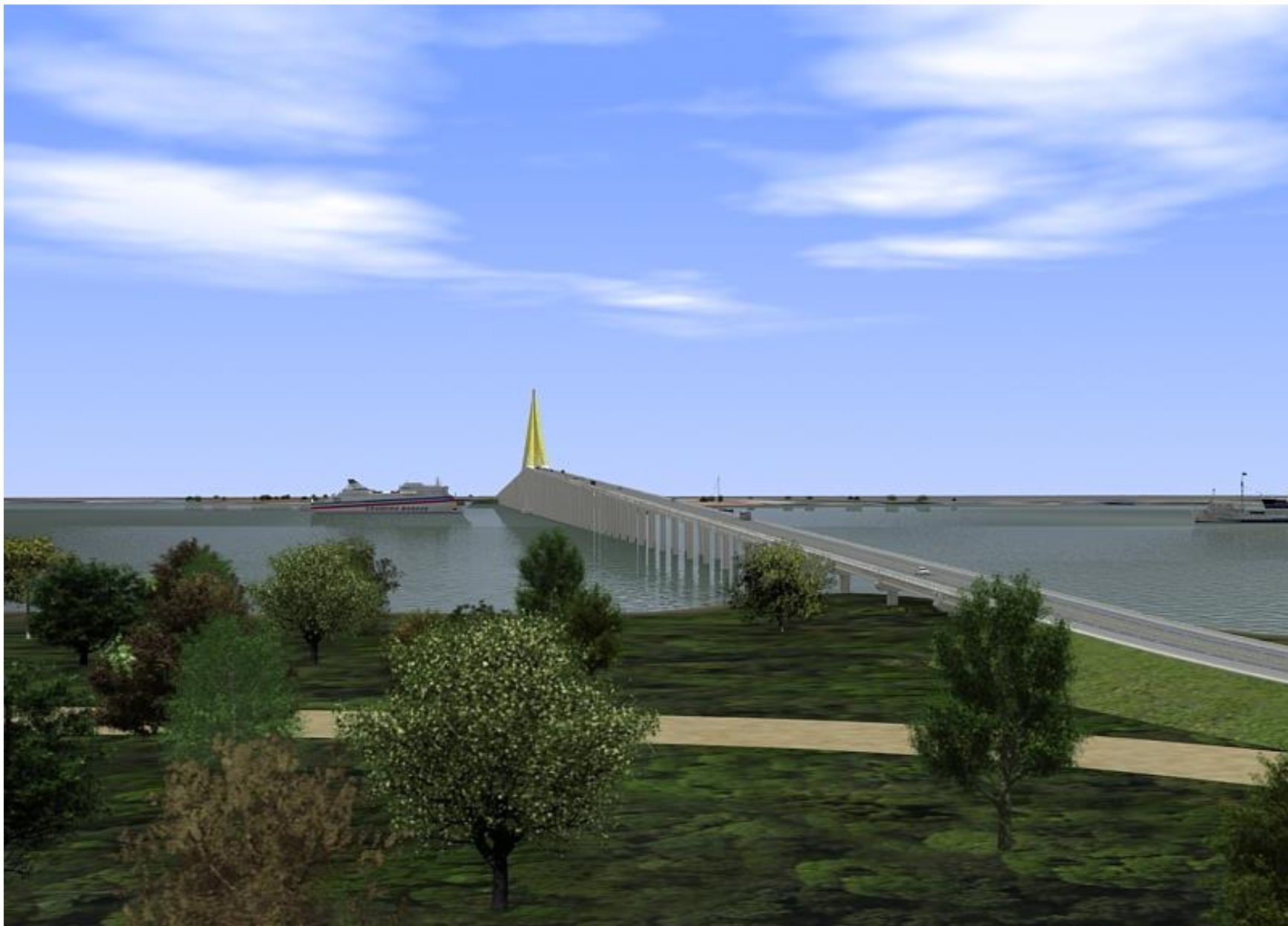
Visão Parcial da Ponte sobre o rio Negro - Cabeceira da Ponta do Ouvidor - Visão Lateral
