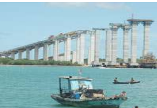
Andamento atual das obras da ponte sobre o rio Potengi, Natal-RN
