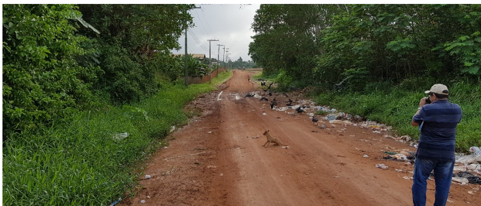
Foto 23. Arruamento de acesso - Aterro Sanitário de Itacoatiara.
