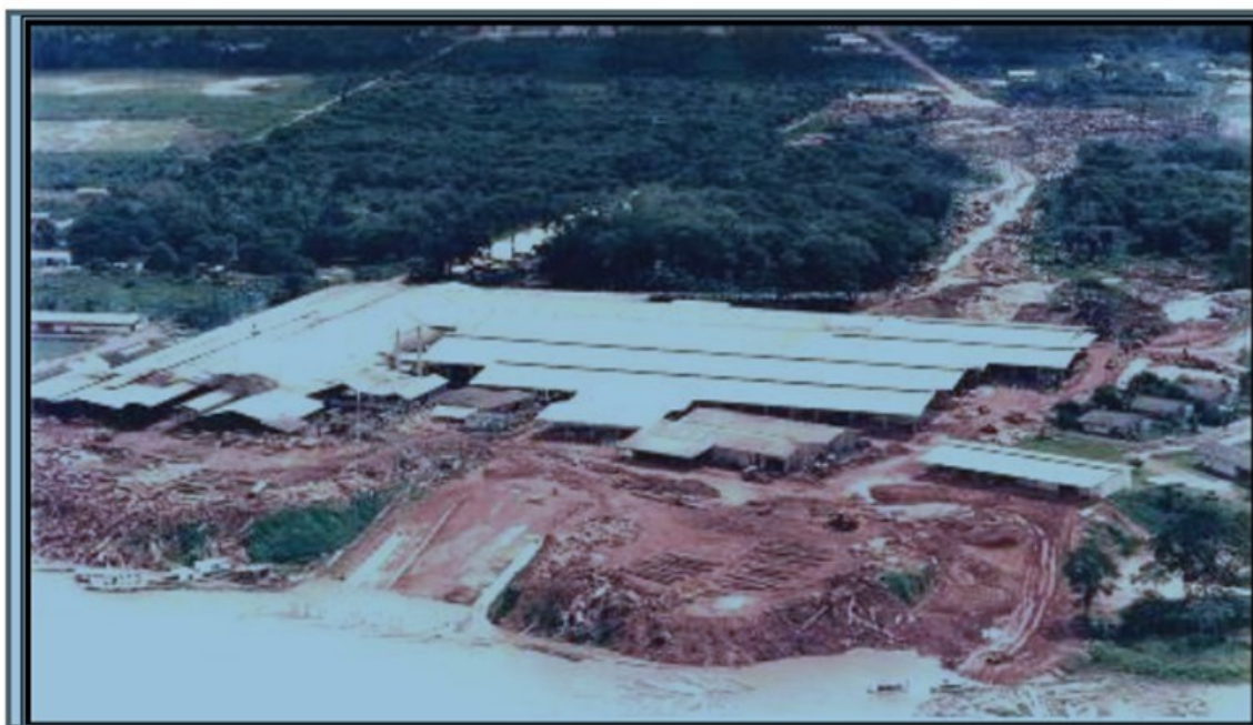
Foto 1. Instalações do empreendimento (Antiga Gethal Amazonas em 1986).
