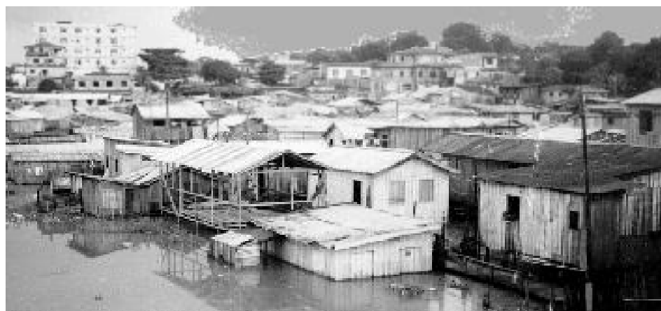
Figura 17. Casas do tipo palafitas construídas na planície de inundação do igarapé do Quarenta, bairro Morro da Liberdade
