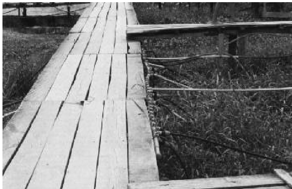
Figura 20. Conexões realizadas pela concessionária para abastecer as palafitas das margens do igarapé.
