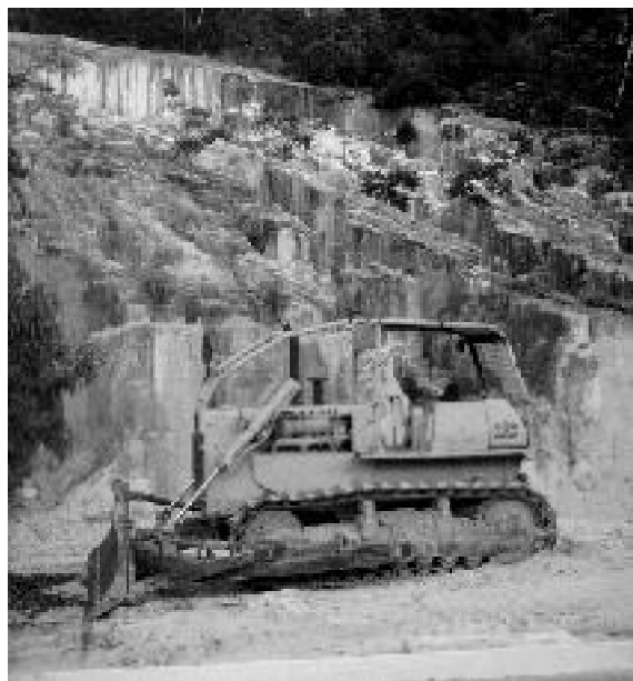
Figura 5. Erosão na Área do Distrito Industrial.
