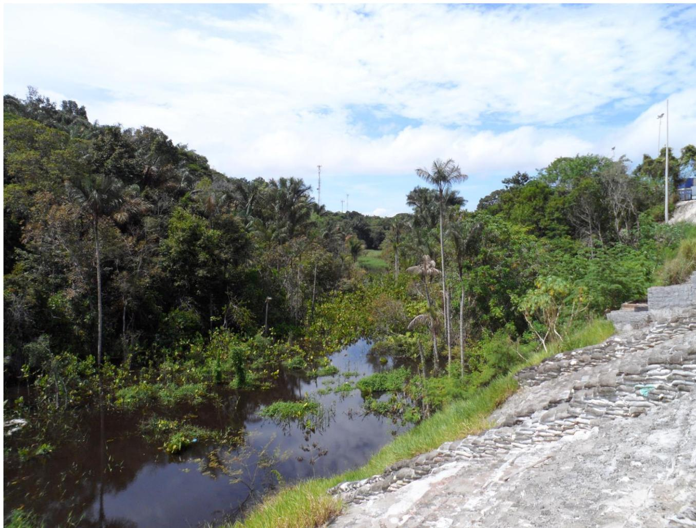
Foto 4. Proteção da encosta da margem direita do igarapé Bom Jardim
