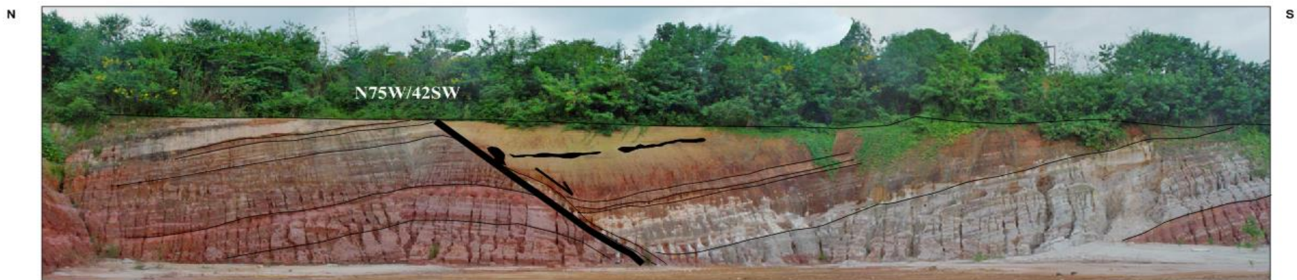
Foto 6. Corte em Talude (norte-sul) no Porto ATR (Porto Chibatão), Bairro Colônia Oliveira Machado, onde pode ser observada a zona de falha que afetou as camadas da Formação Alter do Chão (níveis arenoso/ferruginoso, a esquerda, e o argilo-arenoso/caulinítico). A zona de falha corta todo o perfil, colocando lado a lado, as duas camadas. Notar a rotação das camadas promovida pela falha.
