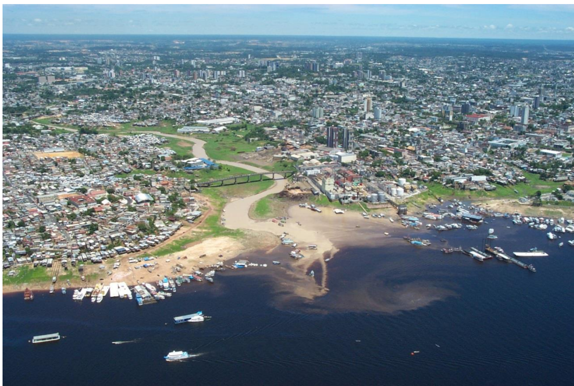
Foto 26. Erosão fluvial na margem esquerda do Rio Negro. Imediações da Ponte do São Raimundo-Aparecida.
