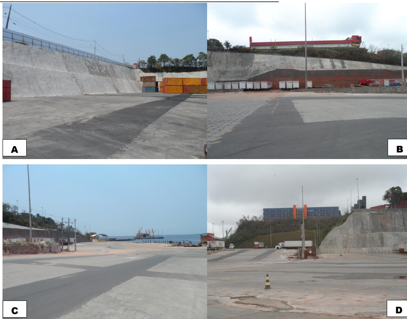
Foto 23. (A), (B), (C) (D) área de instalação do Porto Chibatão, com serviço de engenharia para a contenção de encostas
