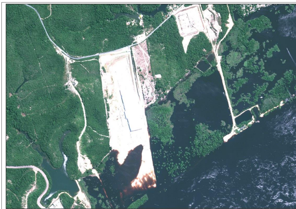
Foto 19. Processos geomorfológicos ocasionados por remoção da camada vegetal (O 59°51'22,05" ; S 03°04'15,64")
