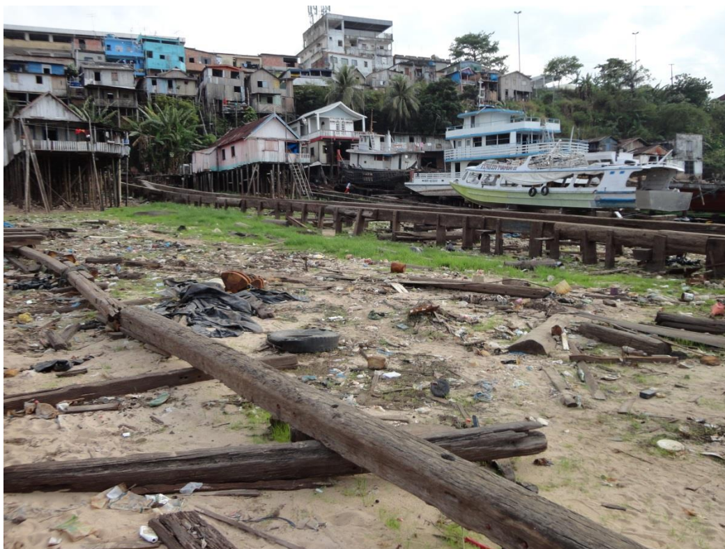
Foto 20. Ocupação irregular de áreas com declividade acentuada na orla do Rio Negro.
