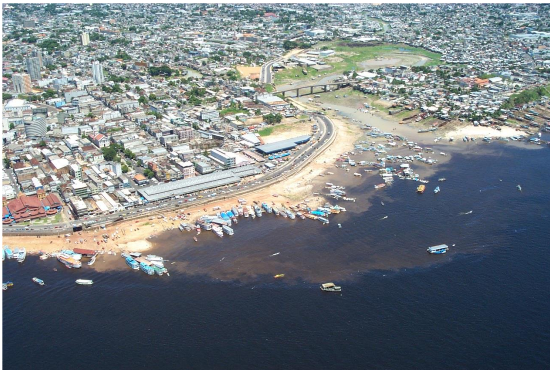
Foto 27. Erosão fluvial na margem esquerda do Rio Negro. Imediações da Ponte Centro-Educandos.
