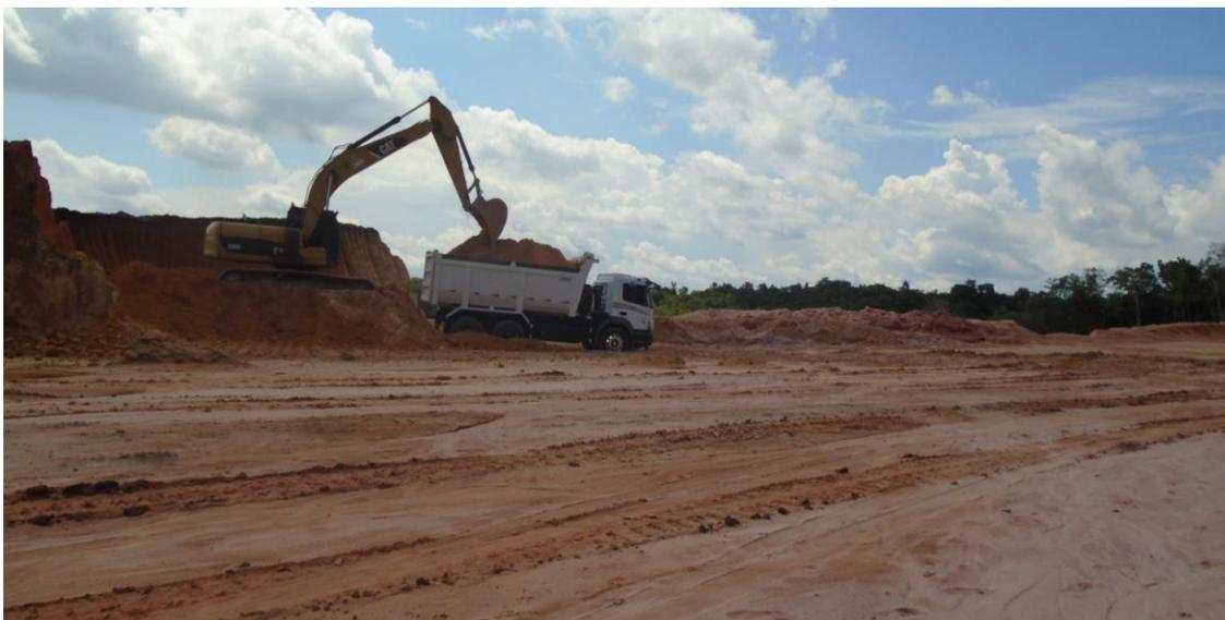
Foto 13. Carregamento de caminhão tipo caçamba por meio de escavadeira hidráulica na área da mina da Polimix Concreto Ltda.
