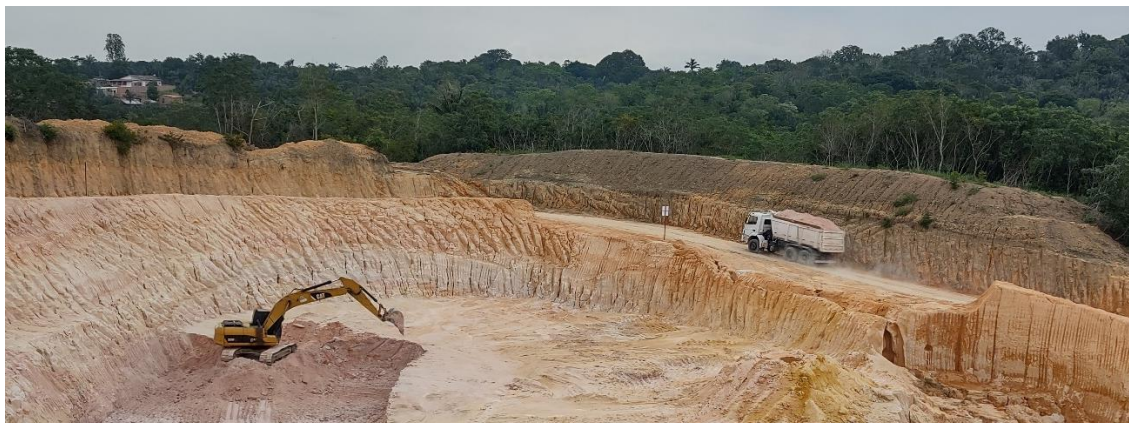
Foto 1. Escavadeira e caminhão do tipo caçamba utilizados nas operações do empreendimento.
