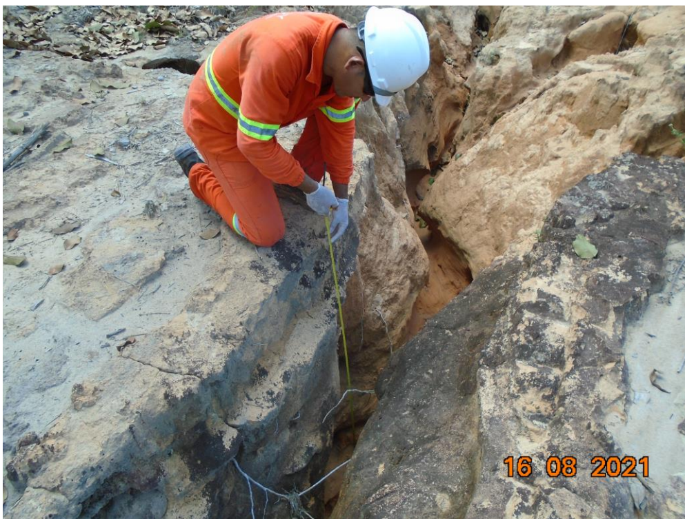
Foto 23. Aspecto do Processo Erosivo (sulcos e ravinas de erosão) como consequência da concentração de fluxo d'água na área 3 (PT – A3 – F4).
