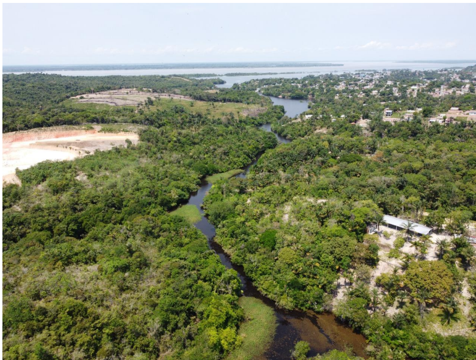
Foto 12. Foto aérea do aspecto dos vales estreitos e fechados da área próxima à ADA e AID.
