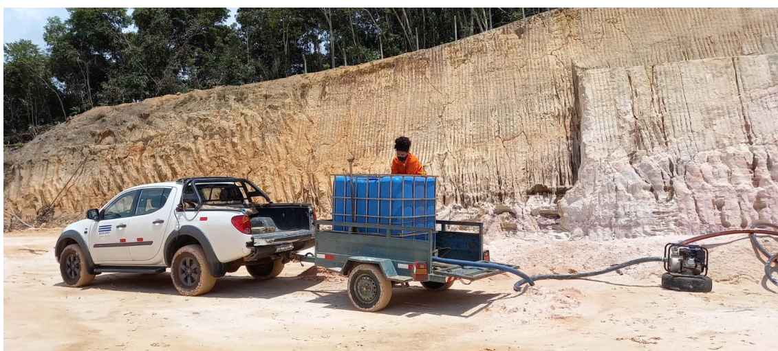
Foto 3. Sistema de hidrossemeadura.
