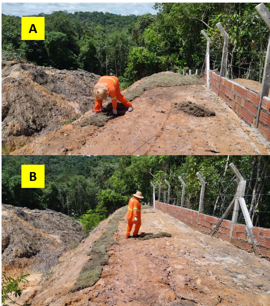
Foto 5. Exemplo de aplicação de grama em placa em porção superior de talude.
