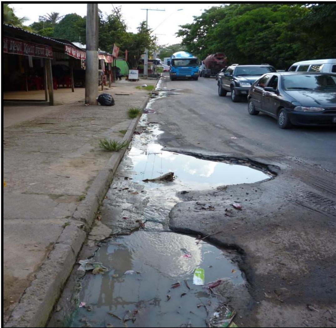
**Figura 52-** *Condições do asfalto local.*
