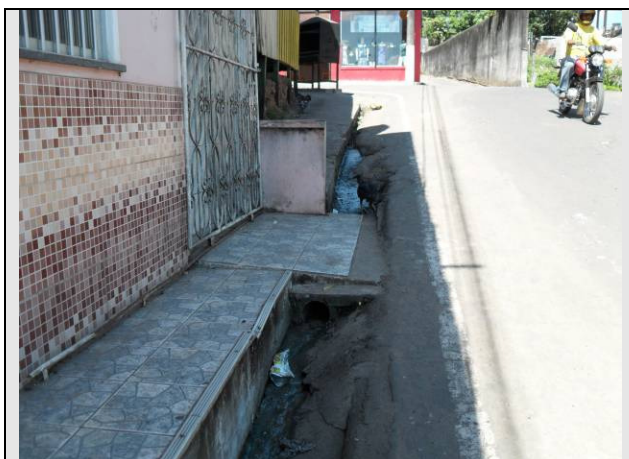
Foto III.3.2.4.3-1 - Esgoto corre a céu aberto pelas ruas da cidade.
