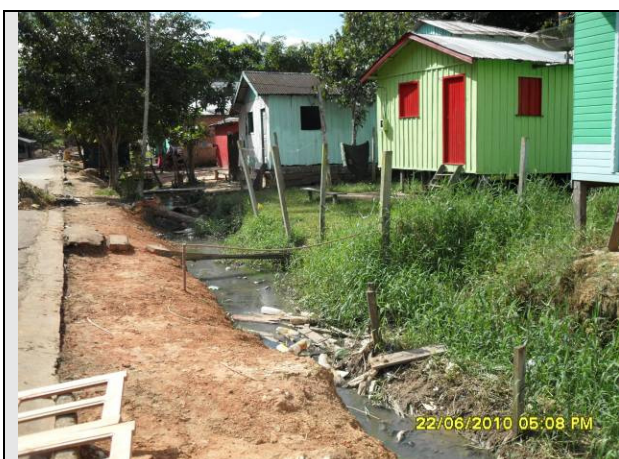
Foto III.3.2.4.3-3 - Bairro urbano onde se encontra acúmulo de esgoto.
