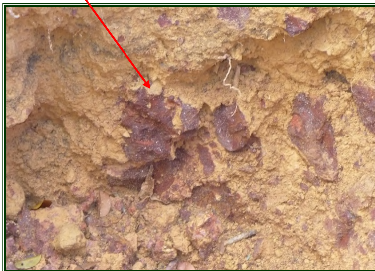
Figura 59B – Detalhe da expressiva plintização nesse horizonte.
