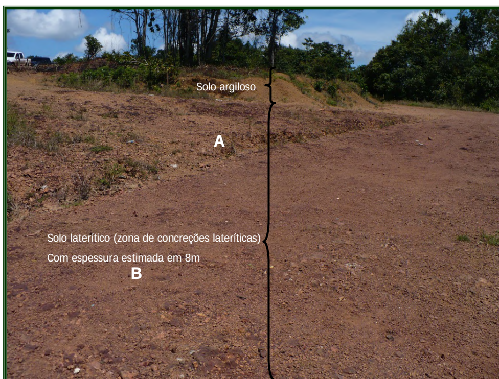
Figura 31 – Afloramento de maciço latossólico com concreções lateríticas em topo de platô, próximo à crista da encosta. A – Topo do perfil, solo argilo-arenoso/siltoso (baixa vulnerabilidade erosiva). B – Na base, maciço laterítico (piçarra) (muito baixa vulnerabilidade erosiva), com grandes possibilidades de uso na construção civil. Localizado na porção central do empreendimento, em topo de platô, Área 23 e Área 24 do Mapa Geotécnico e de Minerais de Uso na Construção Civil.
