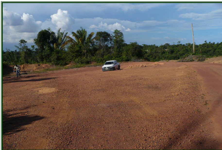
Figura 33 – Afloramento de maciço latossólico com concreções lateríticas em topo de platô, próximo à crista da encosta. Antiga extração de laterita (piçarra). Jazida não exaurida, solo laterítico (muito baixa vulnerabilidade erosiva), com grandes possibilidades de uso na construção civil. Localizado na porção central do empreendimento, Área 11 do Mapa Geotécnico e de Minerais de Uso na Construção Civil.
