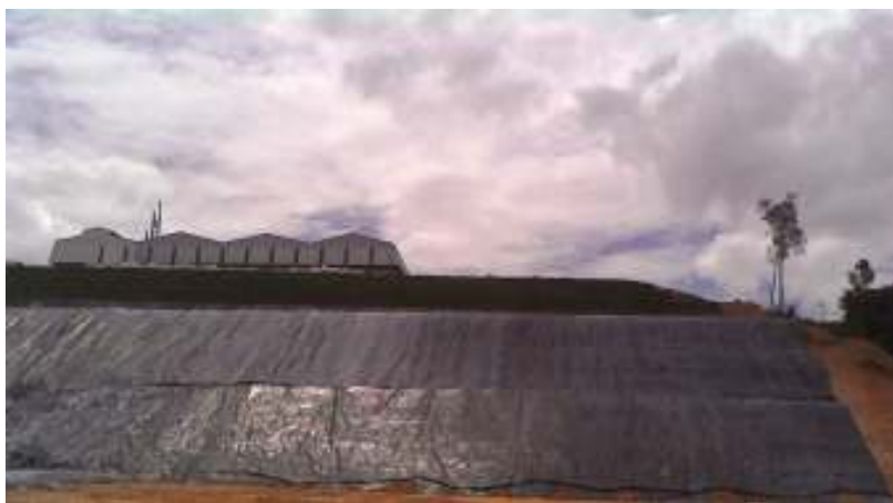
Figura 22. Aterro industrial a ser construído na área do empreendimento.
