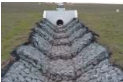
Figura 23 - Descida em gabião
