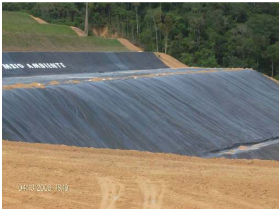
Figura 21. Manta de proteção utilizada no aterro industrial.
