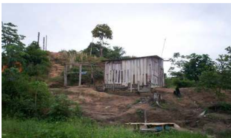
Figura 74. Casa em situação de risco.
