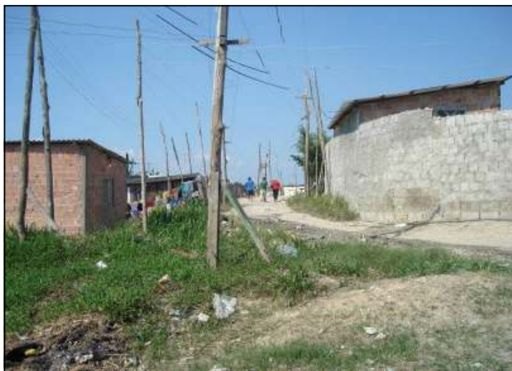
Figura 78. Degradação das ruas por queimada.
