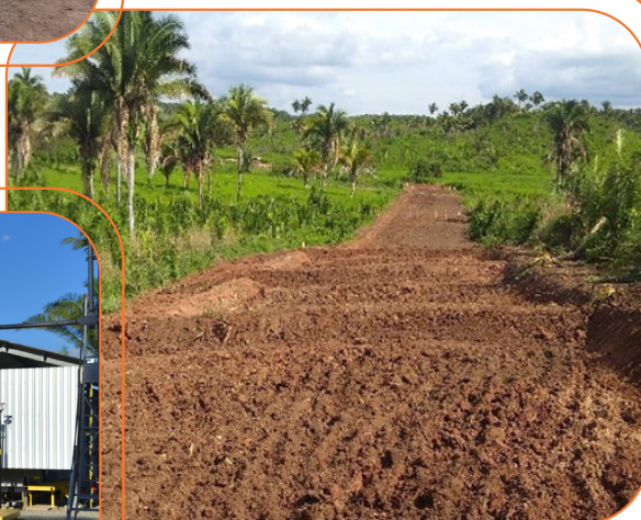
Faixa de recomposta após instalação de duto, no Maranhão.
