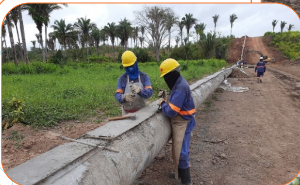
Duto concretado em empreendimento similar, no Maranhão.
