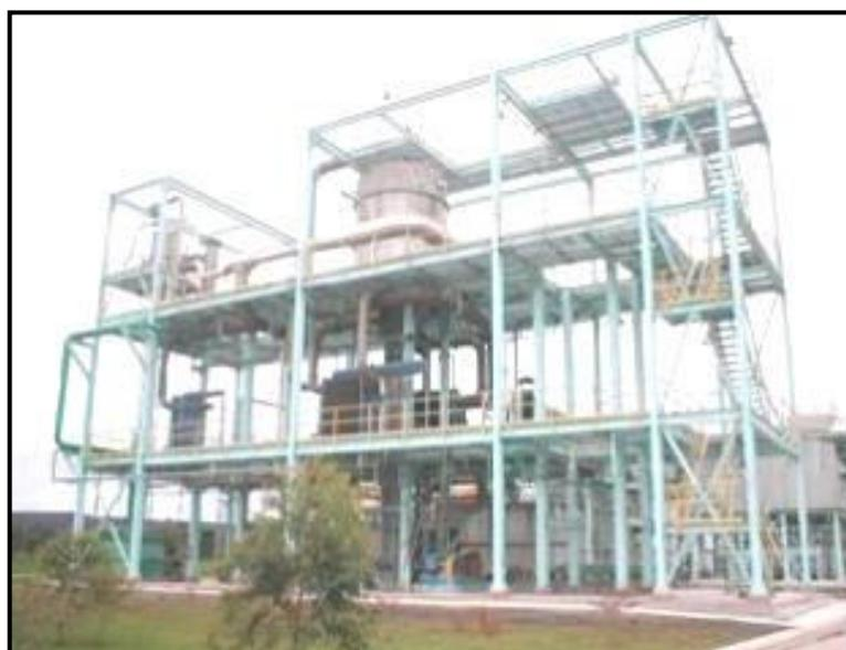
Foto 1.9.1.4.1-5 - Evaporador de simples estágio industrial.
