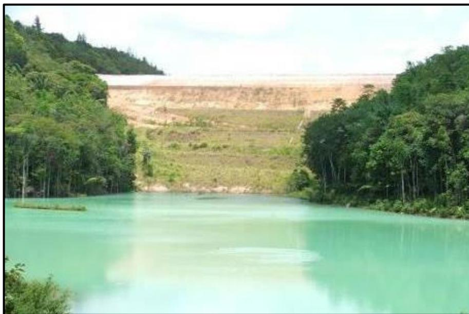
Foto 1.5.2.2-1 - Bacia de contenção de sólidos a jusante de pilha de estéril.
