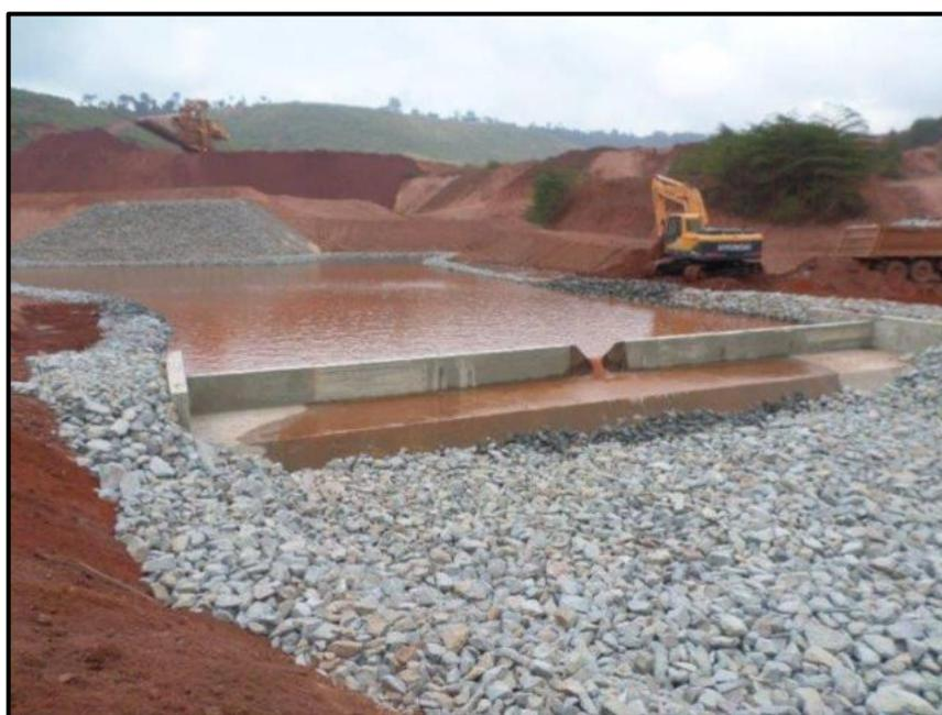
Figura 1.9.1.5.5.3.3-1 - Tapete drenante em construção utilizando pedras calcárias.
