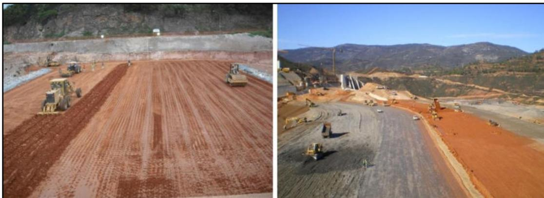
Figura 1.9.1.5.5.1.2-1 - Aterro homogêneo. Operações de escarificação e de compactação.
