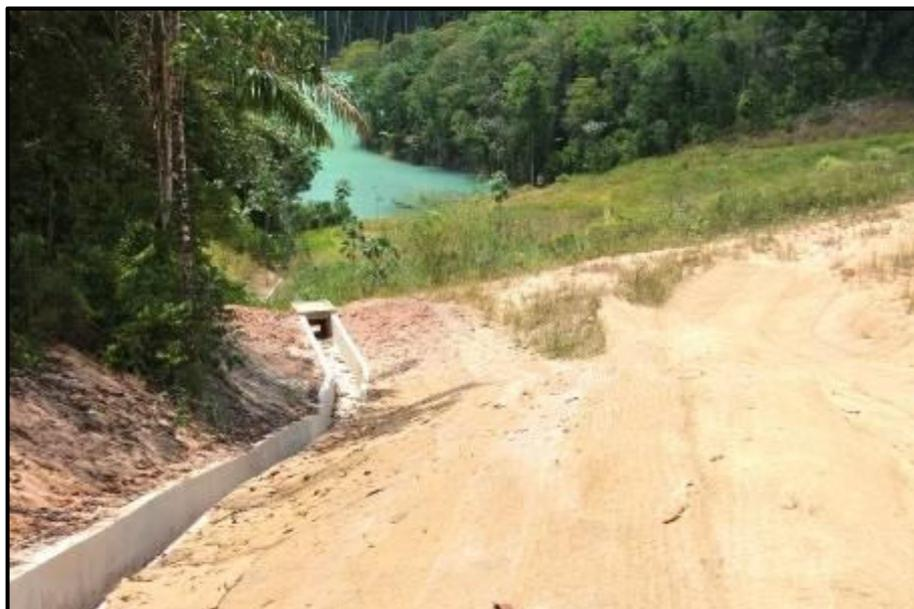
Foto 1.5.2.2-2 - Canaleta de concreto para drenagem lateral em pilha de estéril.
