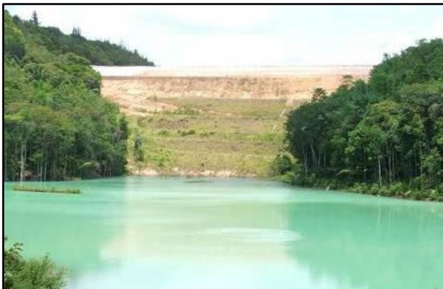
Foto 1.8.2.5-1 – Bacia de contenção de sólidos a jusante de pilha de estéril.
