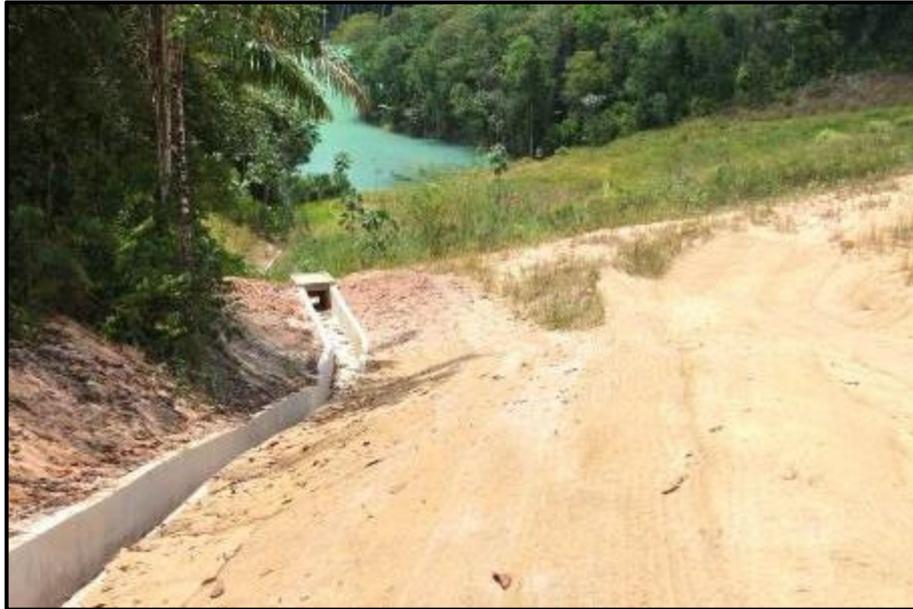
Foto 1.8.2.5-2 - Canaleta de concreto para drenagem lateral em pilha de estéril.
