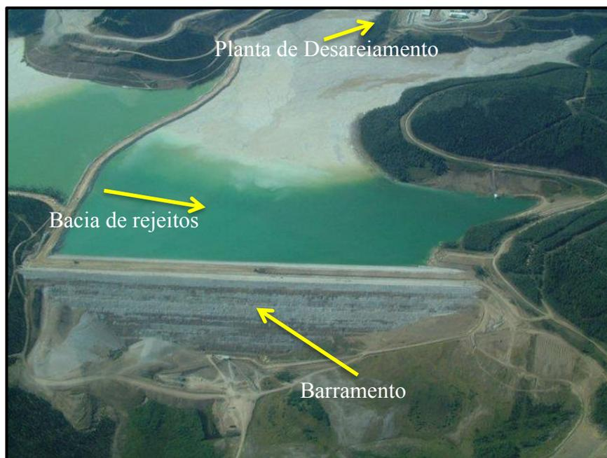
Figura 1.9.1.5.1.3.2-1 - Exemplo de localização de uma bacia de rejeitos.
