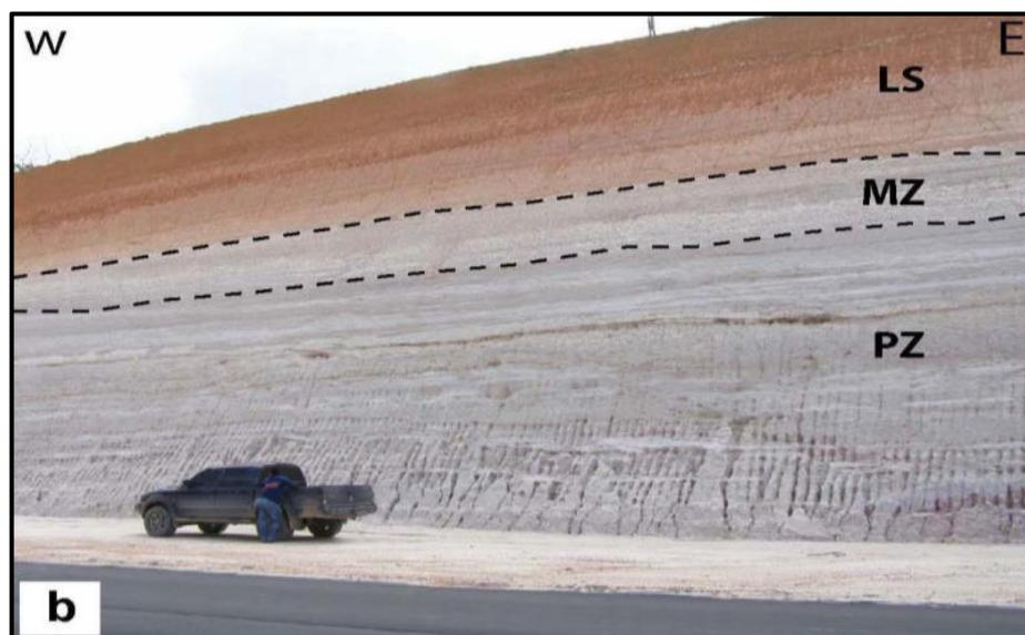
Figura 4.1.7.2.3.3-2 - Corte de estrada na Rodovia AM-010, do topo para a base: horizonte de latossolo (LS) zona mosqueada (MZ) e zona pálida (PZ).
