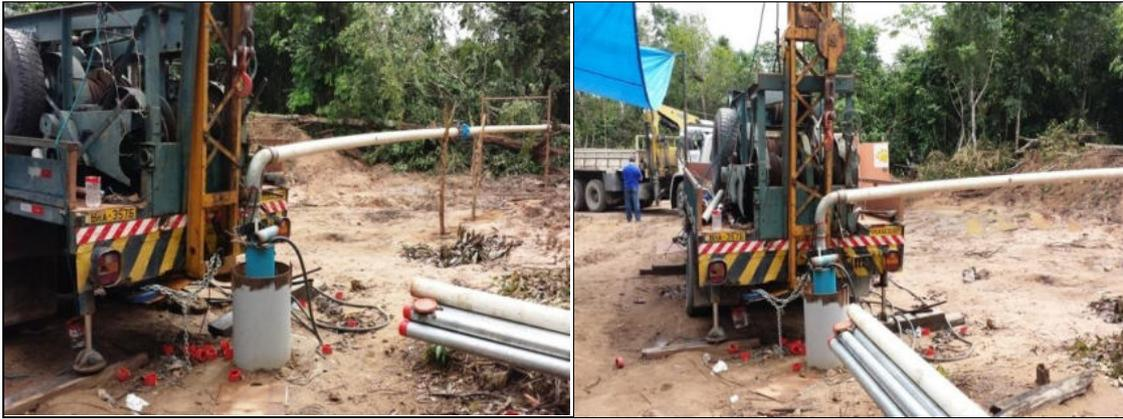
Foto 4.1.7.2.5-1 - Teste de bombeamento, método de descarga livre em tubo horizontal.
