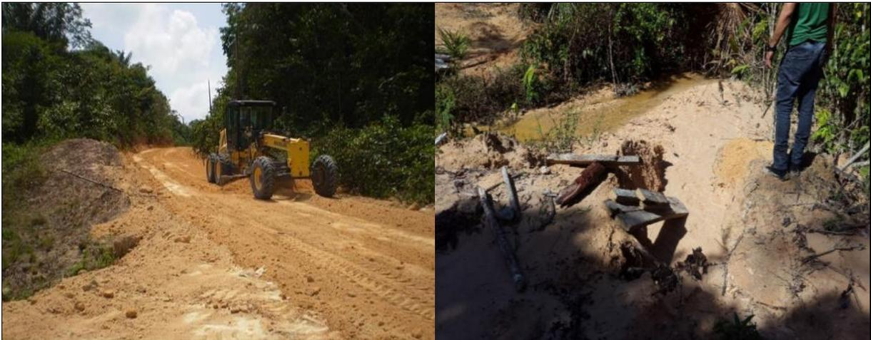
Foto 4.1.5.2.1-3 - Manutenção da estrada, fonte de material para assoreamento dos igarapés.
