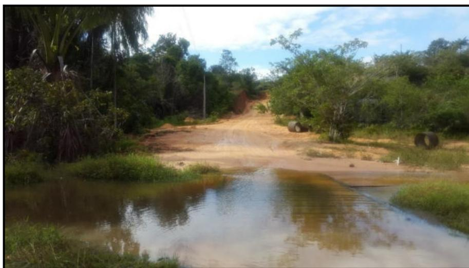
Foto 4.1.5.2.1-1 - Igarapé fluindo por sobre a ponte devido ao assoreamento do leito.
