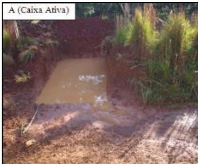
Figura 4.1.5.2.1-2 - Exemplo de aplicação das caixas de infiltração em estrada rural ou vicinal.
