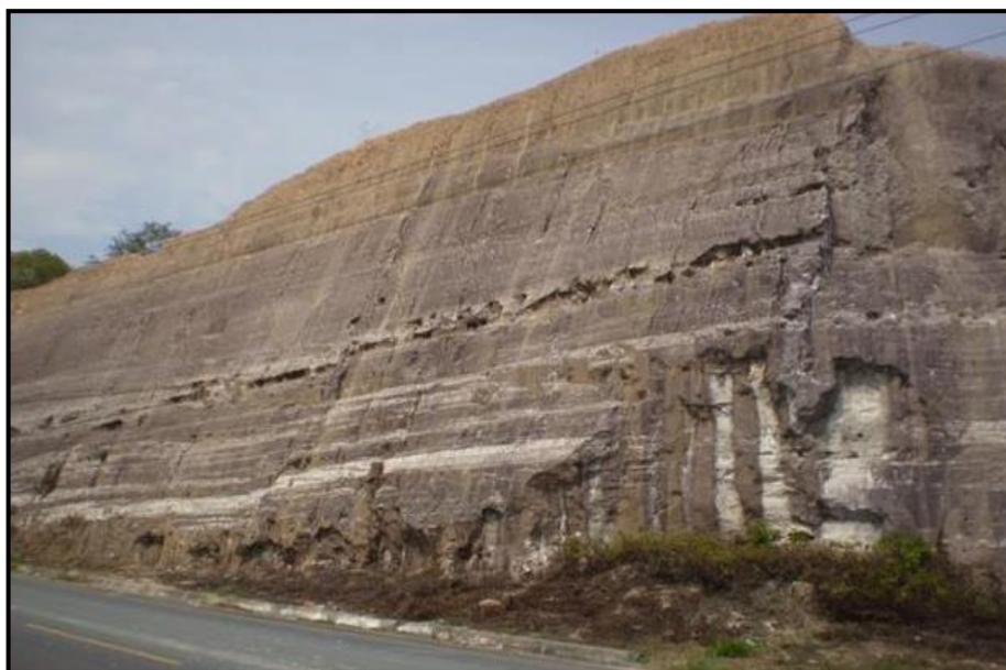
Foto 4.1.6.2-9 - Talude subvertical em latossolo na rodovia AM-010.
