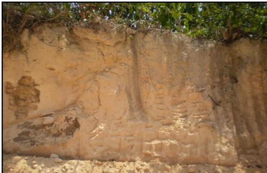
Foto 4.1.6.2-8 - Latossolo com talude subvertical em corte de estrada no interior da área de implantação do empreendimento.
