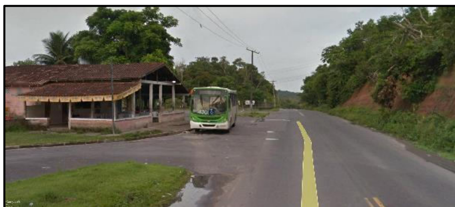
Foto 4.3.3.2.2.3-3 – Rota de Transporte Coletivo, Ramal do Areal.
