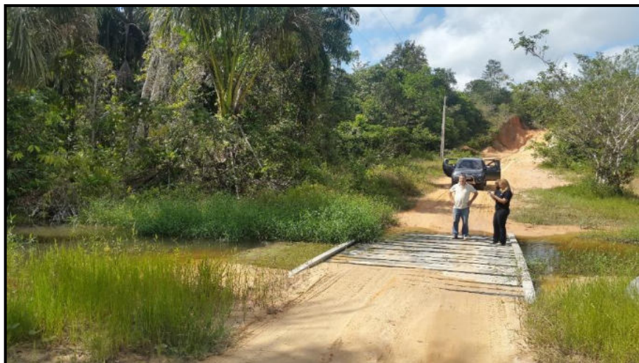
Foto 4.3.6.2.3-4 – Igarapé do Leão cortado pelo ramal do Areal.
