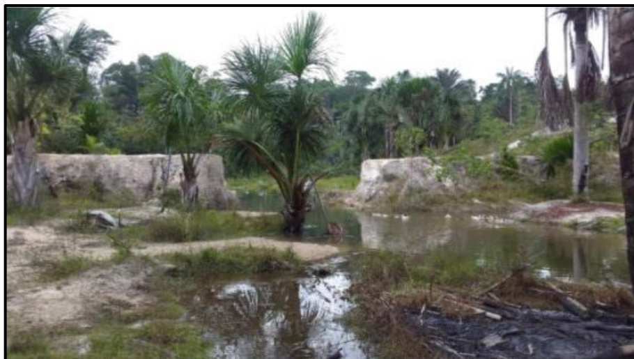
Foto 4.3.6.2.3-9 - Igarapé que entrecorta a parte da extensão, a esquerda, do ramal da União. Nota-se uma elevada degradação e uma barragem rompida.
