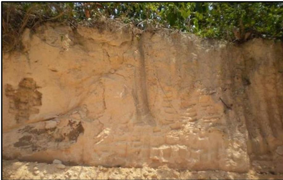
Foto 8.1.12-8 - Latossolo com talude subvertical em corte de estrada no interior da área de implantação do empreendimento.
