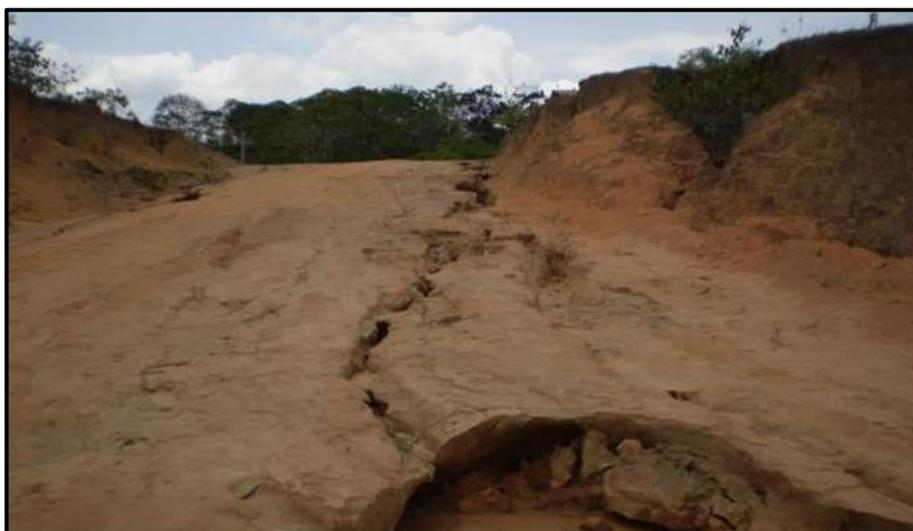
Foto 8.1.12-6 - Sulco de erosão em latossolo como consequência da concentração de fluxo d'água.
