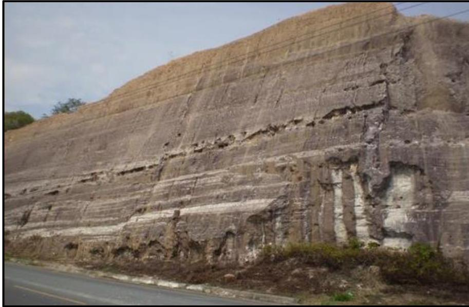
Foto 8.1.12-9 - Talude subvertical em latossolo na rodovia AM-010.
