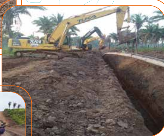
Abaixamento de duto em projeto similar, no Maranhão
