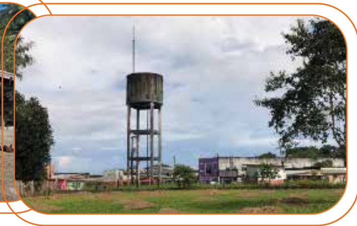
Sistema de abastecimento de água comunitário do município de Itapiranga/AM.
