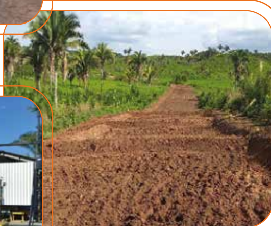
Faixa recomposta após instalação de duto, no Maranhão.
