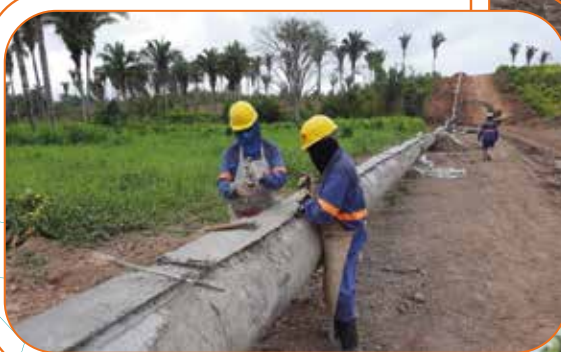
Duto concretado em empreendimento similar, no Maranhão.
