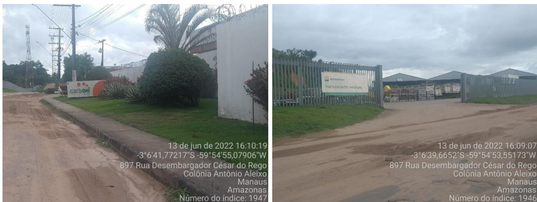
Figura 6 – Aspecto da AID, na área de vizinhança do imóvel onde será a instalação da UTE Manaus II.
