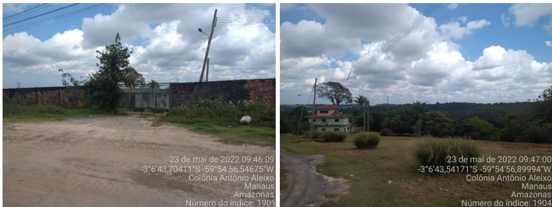
Figura 5 – Entrada do imóvel onde será a instalação da UTE Manaus II.
