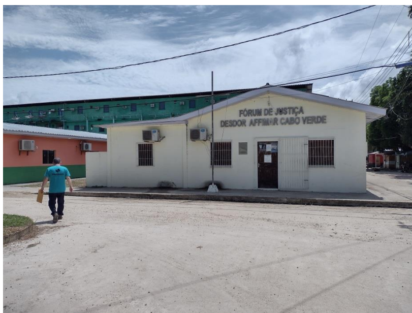
Foto 11 – Sede do Fórum de Justiça, no centro urbano de Japurá ( Fonte: Equipe Técnica).
