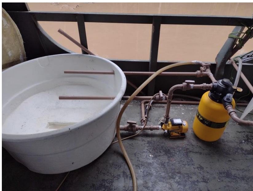
Anexo 6: Foto 2 – Sistema de tratamento de água em tamanho reduzido, instalado na embarcação de apoio, para servir de experimento e atendimento às necessidades humanas de alimentação e higiene pessoal, durante os trabalhos no rio Purué ( Fonte: Equipe Técnica do EIA).
