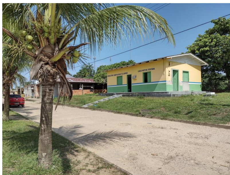
Foto 26 – Consultório odontológico e clínica de prótese dentária, no centro urbano de Japurá (Fonte: Equipe Técnica do EIA).
