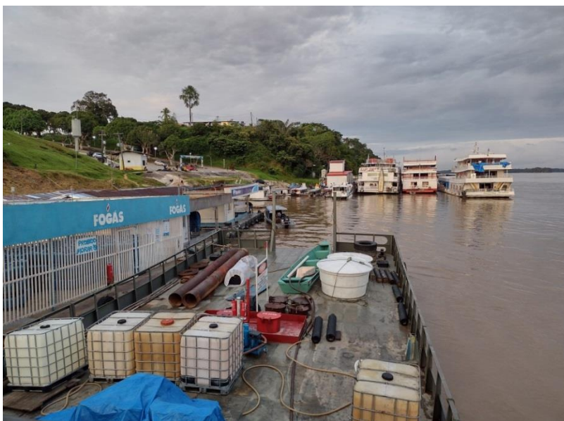
Foto 8 – Aspecto do porto fluvial de Japurá, em que se observa sua pequena estrutura de suporte para atracação, embarque e desembarque de cargas e passageiros ( Fonte: Equipe Técnica).
