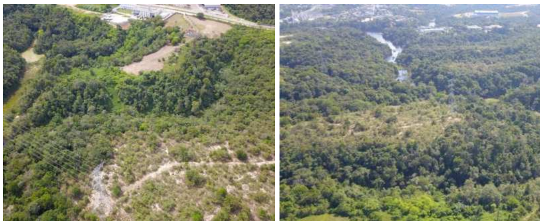
Figura 73 – Área do imóvel da UTE Manaus III, com cobertura vegetal rala nos platôs.
