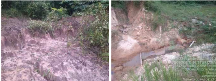
Figura 57 – Aspectos do Latossolo Amarelo e presença de processo erosivo em desenvolvimento
