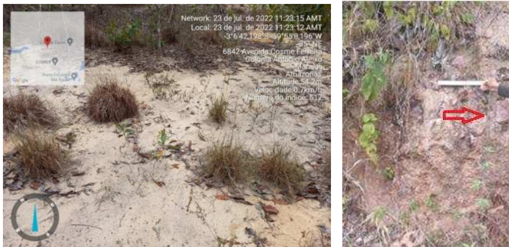
Figura 51 – Aspecto visual do arenito de Manaus que ocorre na área da UTE Manaus.
