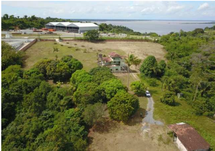
Figura 2 – Foto aérea da localização do imóvel onde fica o site da UTE Manaus III.
