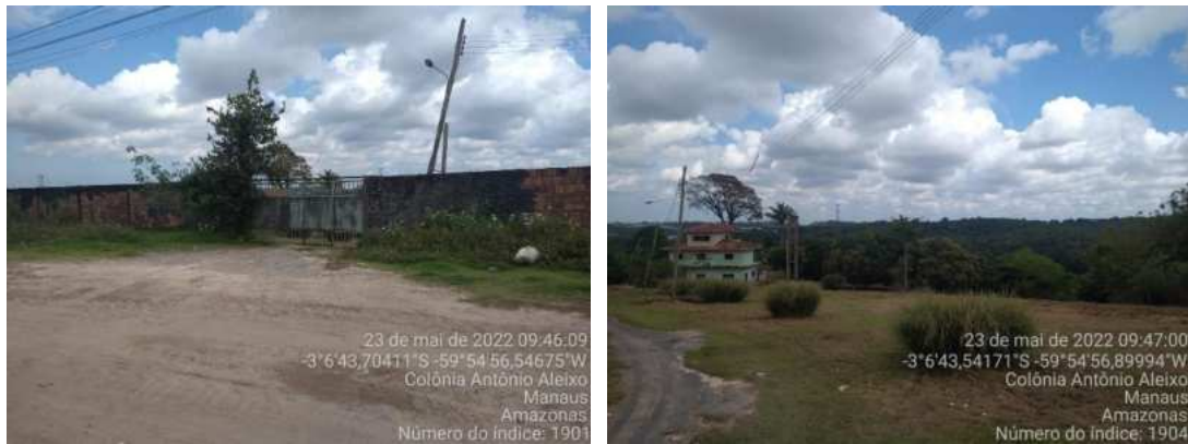
Figura 28 – Entrada Do imóvel onde será a instalação da UTE .
