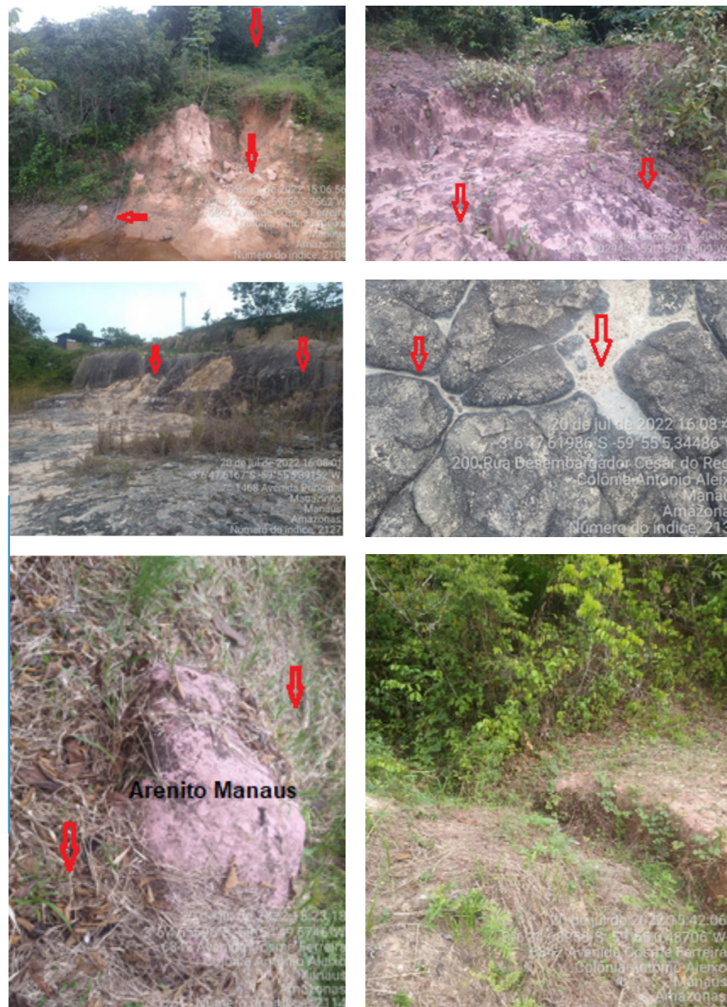
Figura 19 | Locais com processos erosivos na AID da UTE Manaus I
