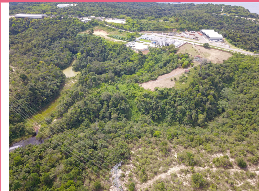
Figura 7 | Foto aérea do imóvel, com indicação do local para instalação da UTE Manaus III
