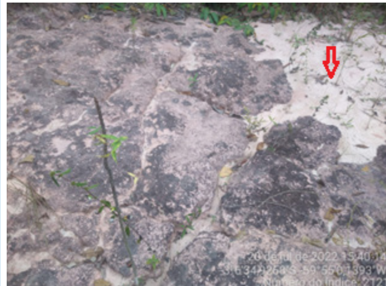
Figura 16 | Identificação dos sedimentos oriundos das erosões
