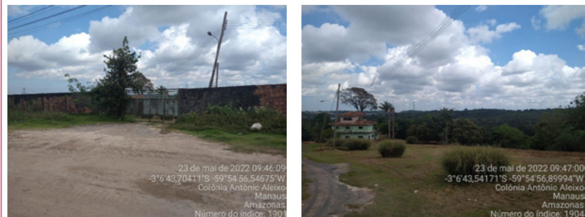
Figura 6 | Entrada do imóvel onde será a instalação da UTE Manaus I
