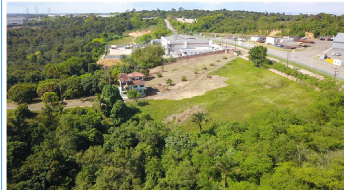
Figura 51 | Usos e ocupações dos solos no imóvel onde será implantada a UTE Manaus I e no seu entorno no Distrito Industrial de Manaus
