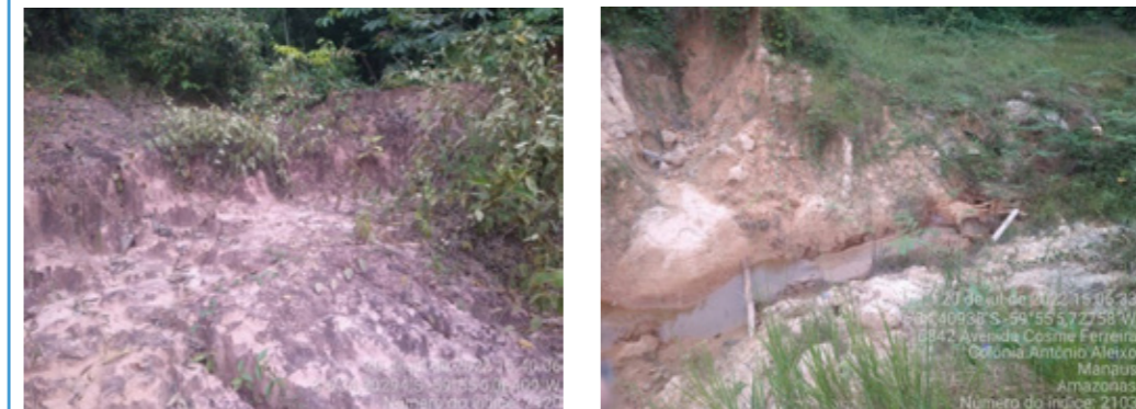
Figura 24 | Aspectos do Latossolo Amarelo e presença de processo erosivo em desenvolvimento
