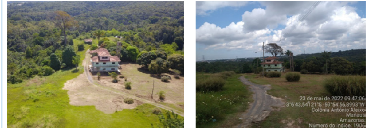
Figura 50 | Edificações existentes na área onde será implantada a UTE Manaus I
