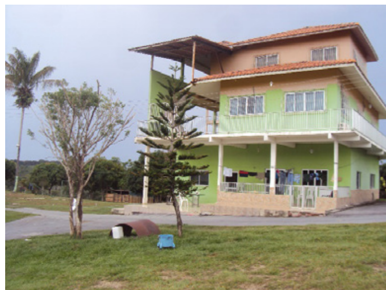
Figura 52 | Edificações existentes na área onde será implantada a UTE Manaus I
