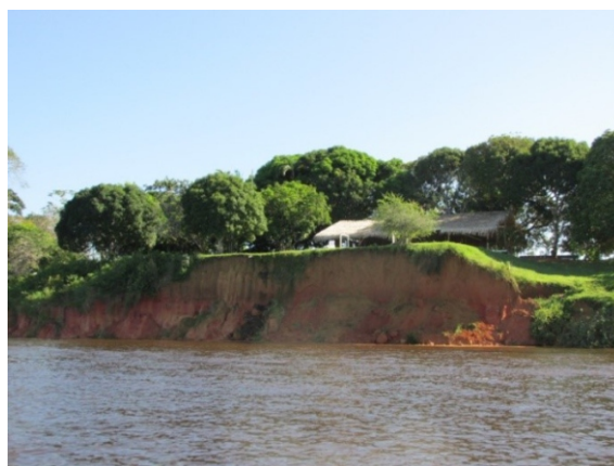
Margem erosiva do rio Amazonas.
