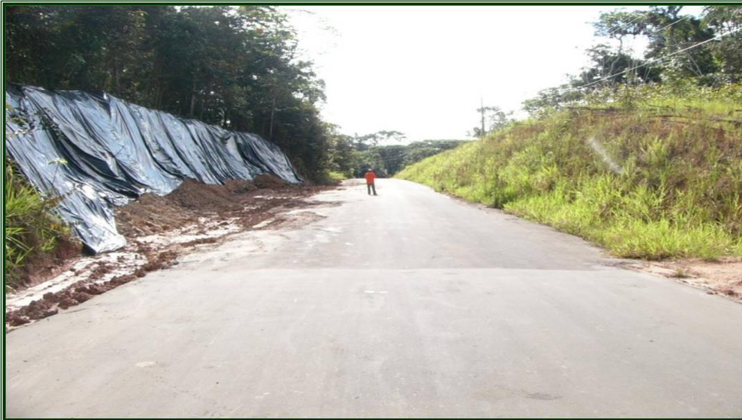
Figura 339 – A cobertura de vertentes com lonas tem auxiliado o controle de erosão, não permitindo o transporte de material para os canais.
