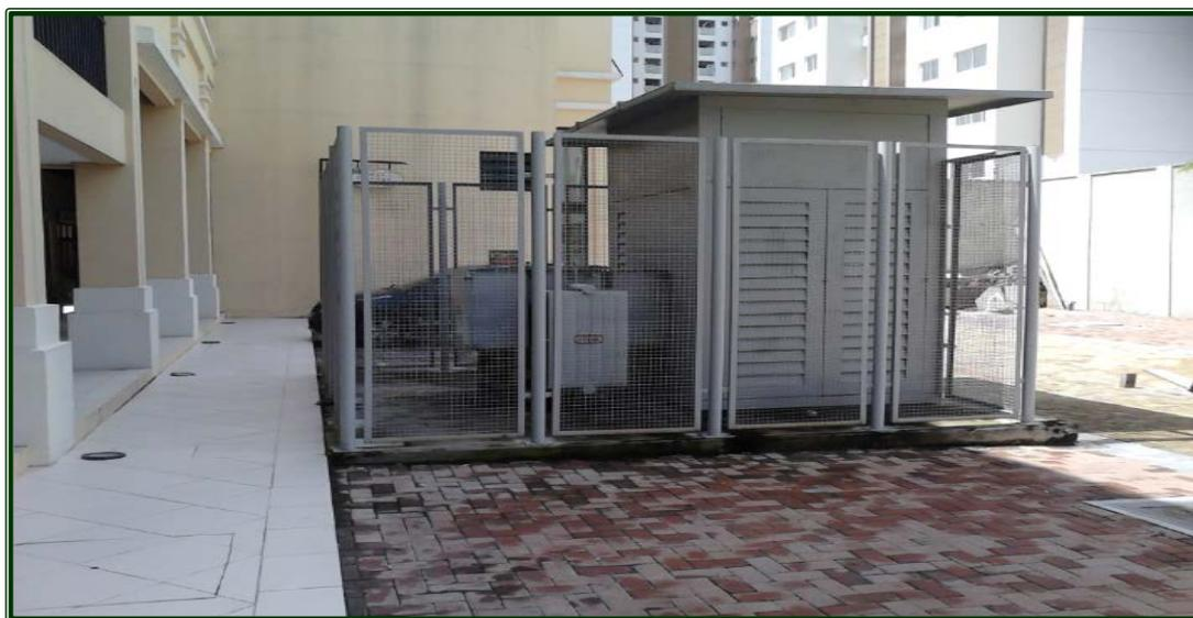
Figura 364 - Exemplo de uma Rede Subterrânea com Posto de Transformação em superfície.
