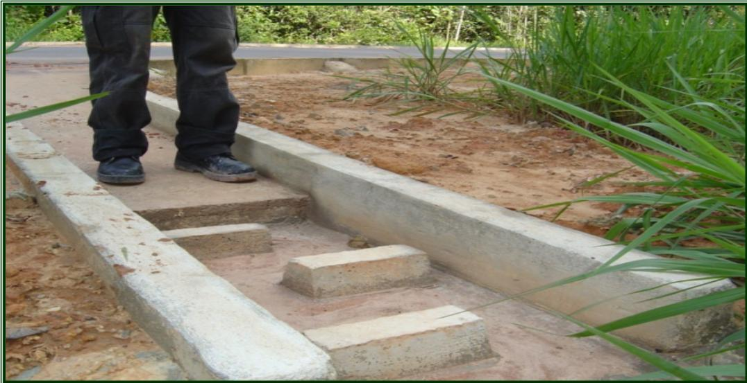
Figura 343 – Modelo alternativo de canaletas com dissipadores de fluxos.
