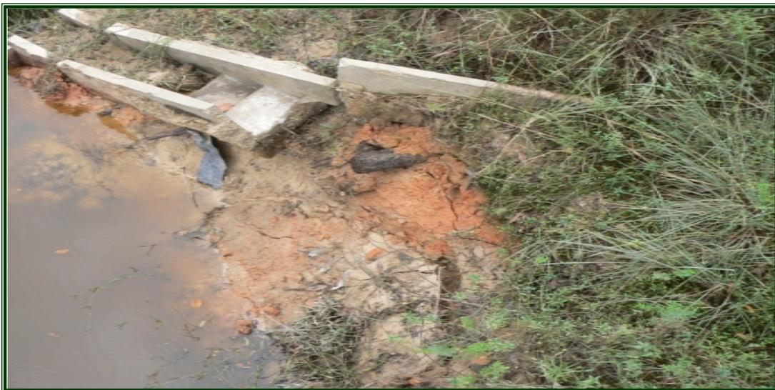
Figura 342 - Canaleta direcionada para o canal.
