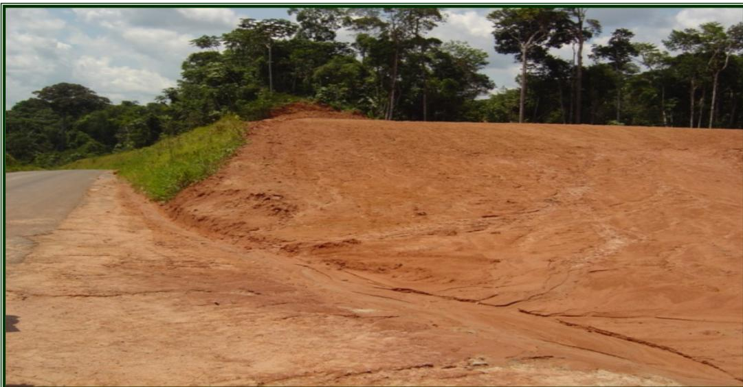
Figura 344 - A exposição de taludes é um procedimento que deve ser evitado.
