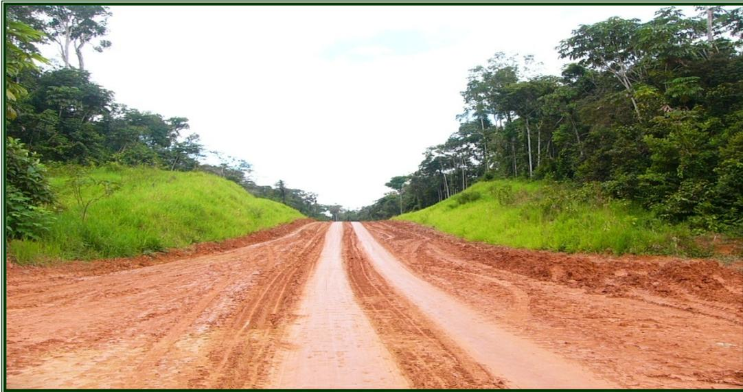
Figura 345 – A cobertura com grama auxilia a contenção de processo erosivo.
