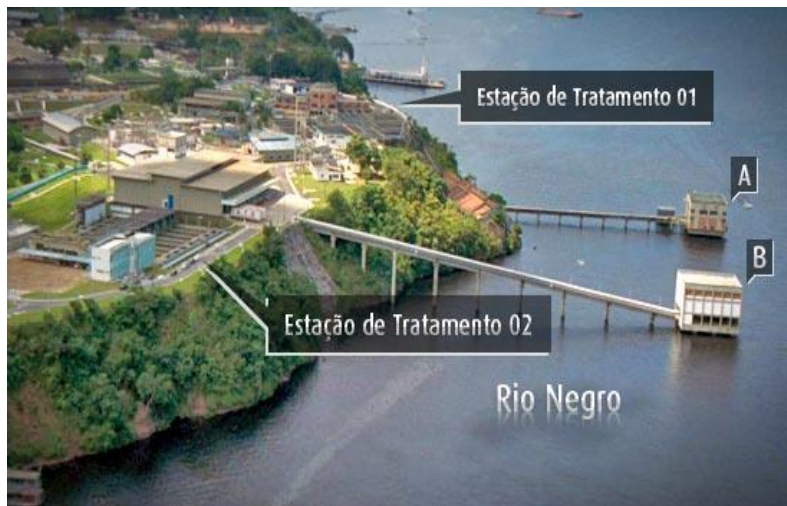
Figura IVA.3 32. Vista aérea das unidades de captação, bombeamento e tratamento da empresa Águas do Amazonas. Fonte: http://www.aguasdoamazonas.com.br/plano.php?nomeArquivo=unidades-captacao .
