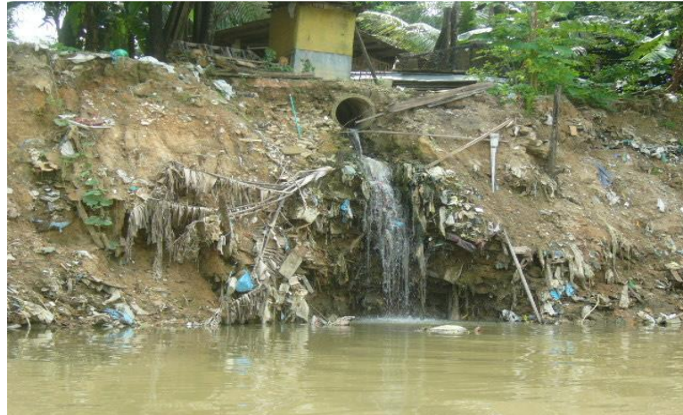
Figura IVA.3 37. Lançamento de esgoto no igarapé do São Raimundo.
